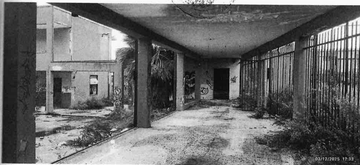
Foto n. 6 - Porticato di collegamento tra corpi di fabbrica del compendio immobiliare
