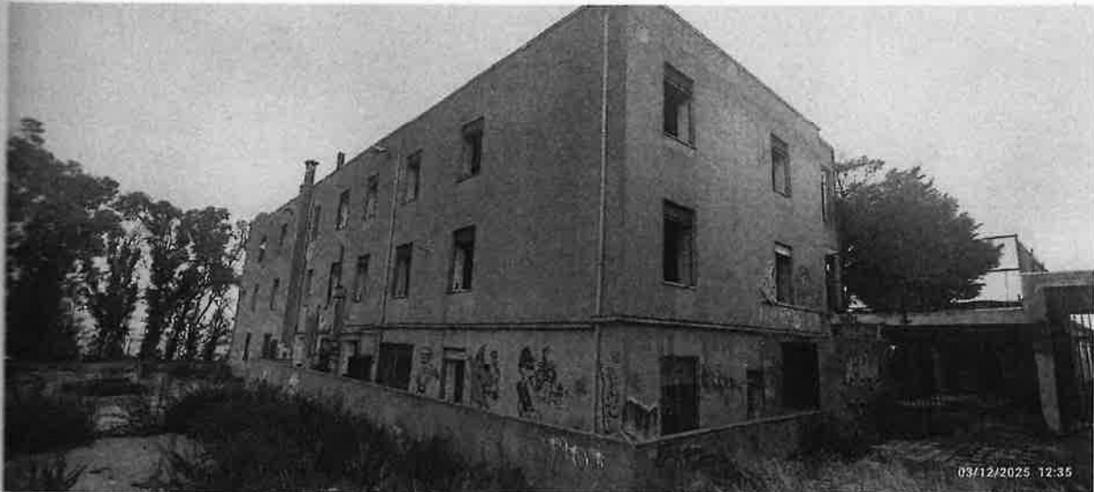
Foto n. 8 - Vista dell'immobile già destinato a Centro di Accoglienza per Immigrati dalla corte esterna
