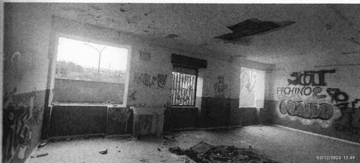
Foto n. 12 - Vista dell'immobile già destinato a Centro di Accoglienza per Immigrati dall'interno
