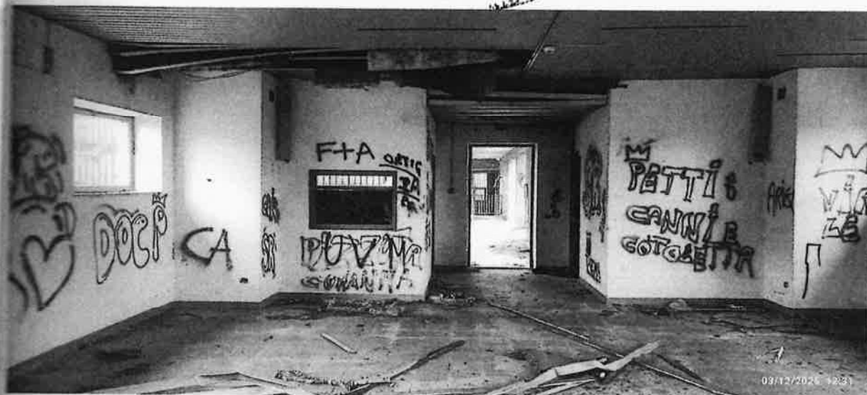
Foto n. 16 - Vista dell'immobile destinato a Teatro dall'interno
