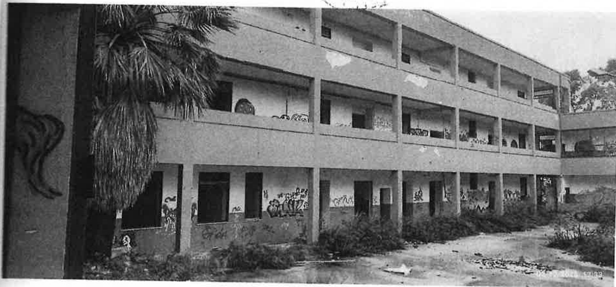
Foto n. 4 – Vista dell’immobile già destinato a Centro di Accoglienza per Immigrati dal cortile interno
